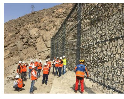
A diferencia de los muros convencionales rígidos de concreto o mampostería, las barreras dinámicas contra flujo de detritos son sistemas flexibles, conformados por redes de anillos circulares que absorben la energía de impacto y que es trasmitida a los anclajes perimetrales del cauce.
