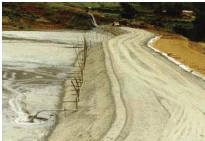
La presa existente es zonificada. Consiste en un núcleo central impermeable construido con una grava arcillosa (GC); un hombro aguas arriba compuesto por relaves secos no ácidos (SP) y los hombros aguas abajo constituidos por relaves gruesos y relleno de escombros de mina (SP y GM).
