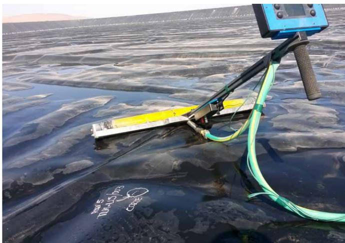
Se determinó, en conjunto con el cliente, aplicar un método electrónico de aseguramiento AGDF (Análisis Geoeléctrico de Detección de Fugas) sobre toda la integridad del sistema de impermeabilización, los que fueron ejecutados en los reservorios #4 y #5. Esta metodología aseguraría la identificación de manera electrónica cualquier nivel de imperfecciones (desde 1.4 mm).
