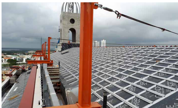
Impermeabilización de cubiertas con membrana Ice And Water Shield.
