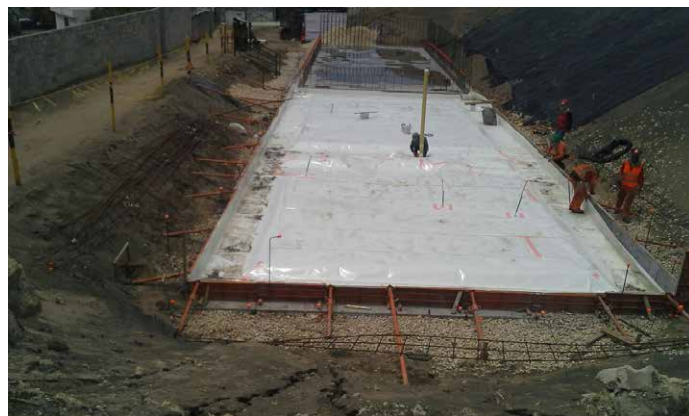
Impermeabilización con membrana Preprufe 300
