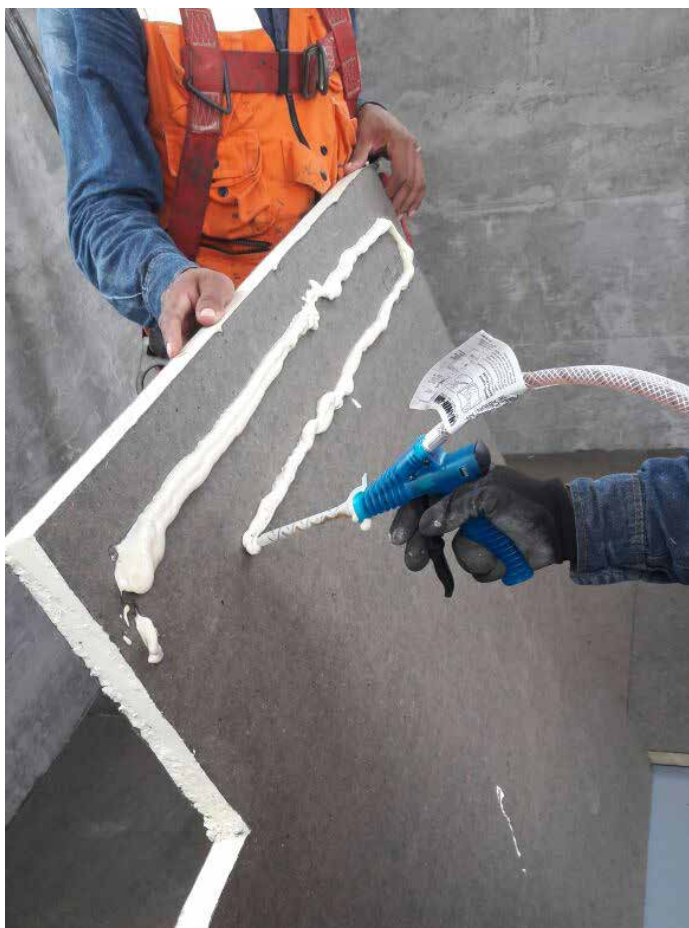
Viga canales y campanario con Polyisocianurato con aislamiento térmico acústico adherido e impermeabilización con membrana adherida de PVC, sistemas Carlisle.
