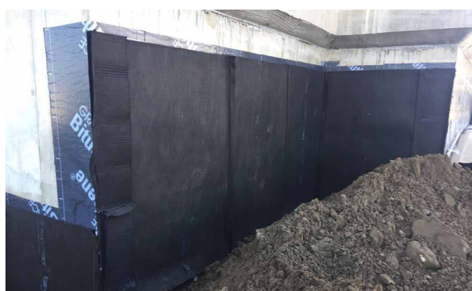
Impermeabilización de muros enterrados con Bituthene 4000 e Hidroducto como sistema de drenaje.
